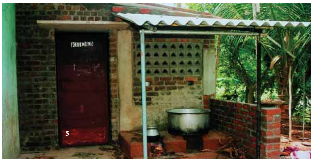
Construction de la cuisine à l'orphelinat du Pasteur John à Mamallapuram.
